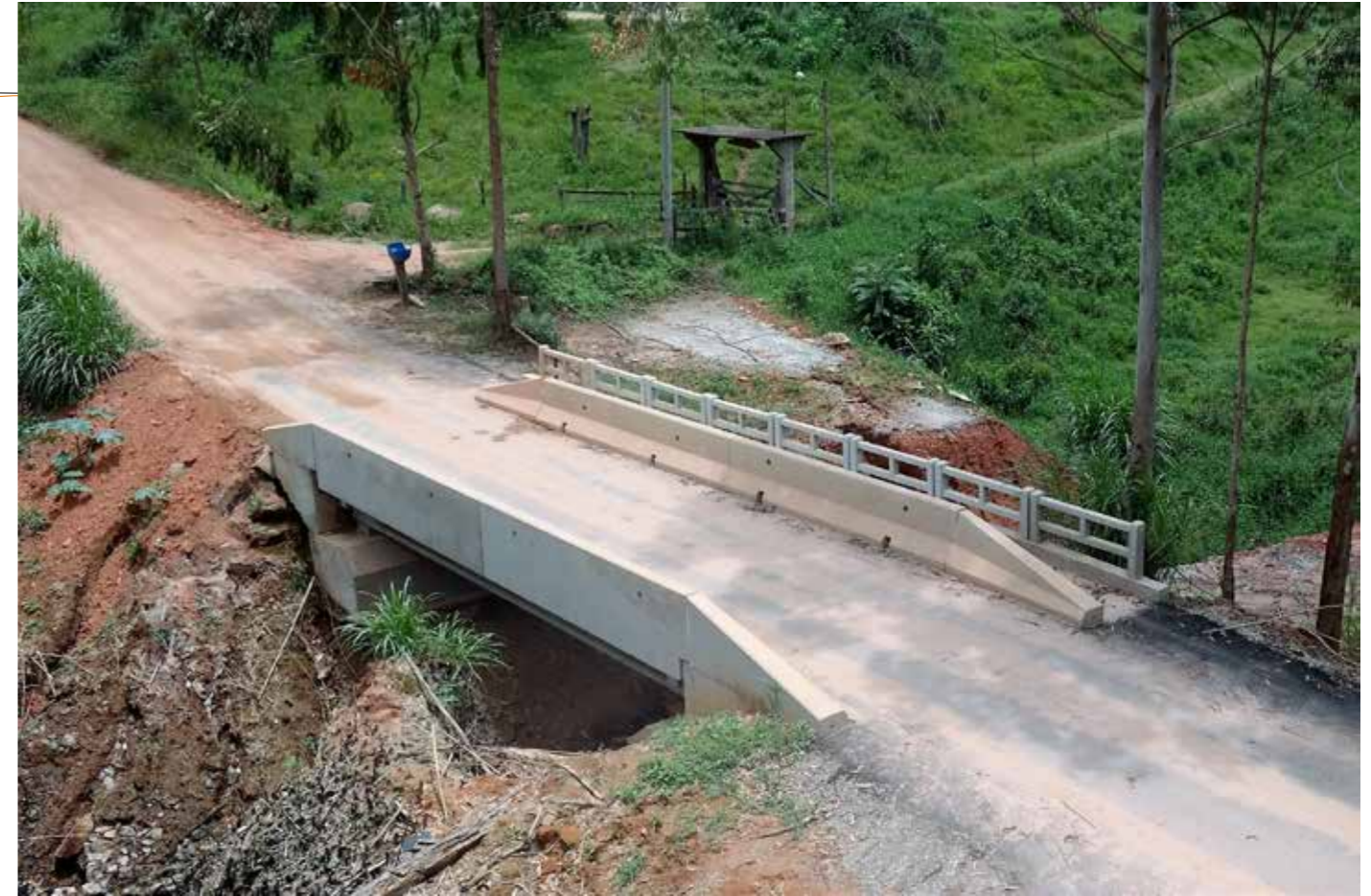
Vista da obra recém-concluída.
