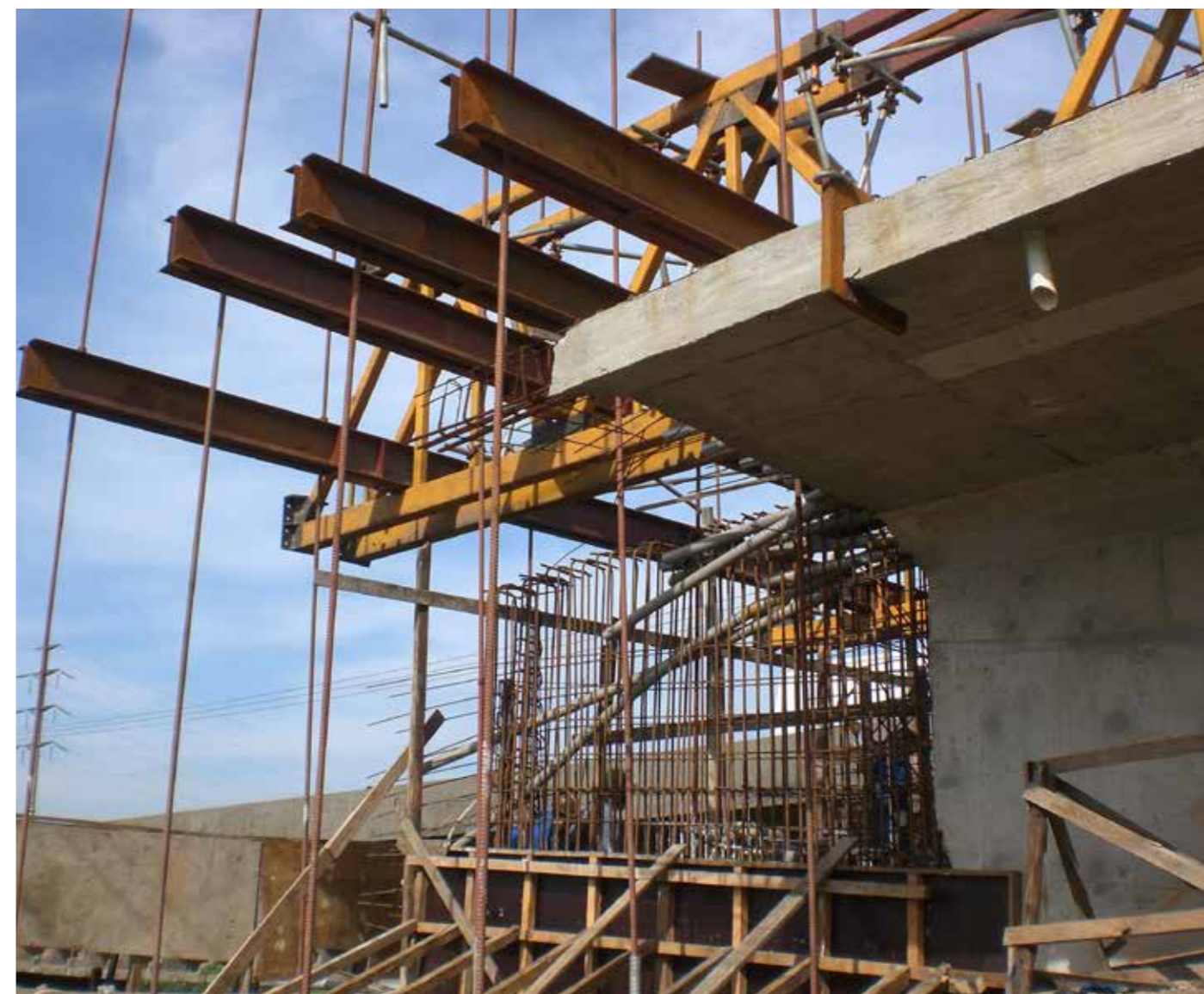
Detalhe da construção das primeira aduelas.
