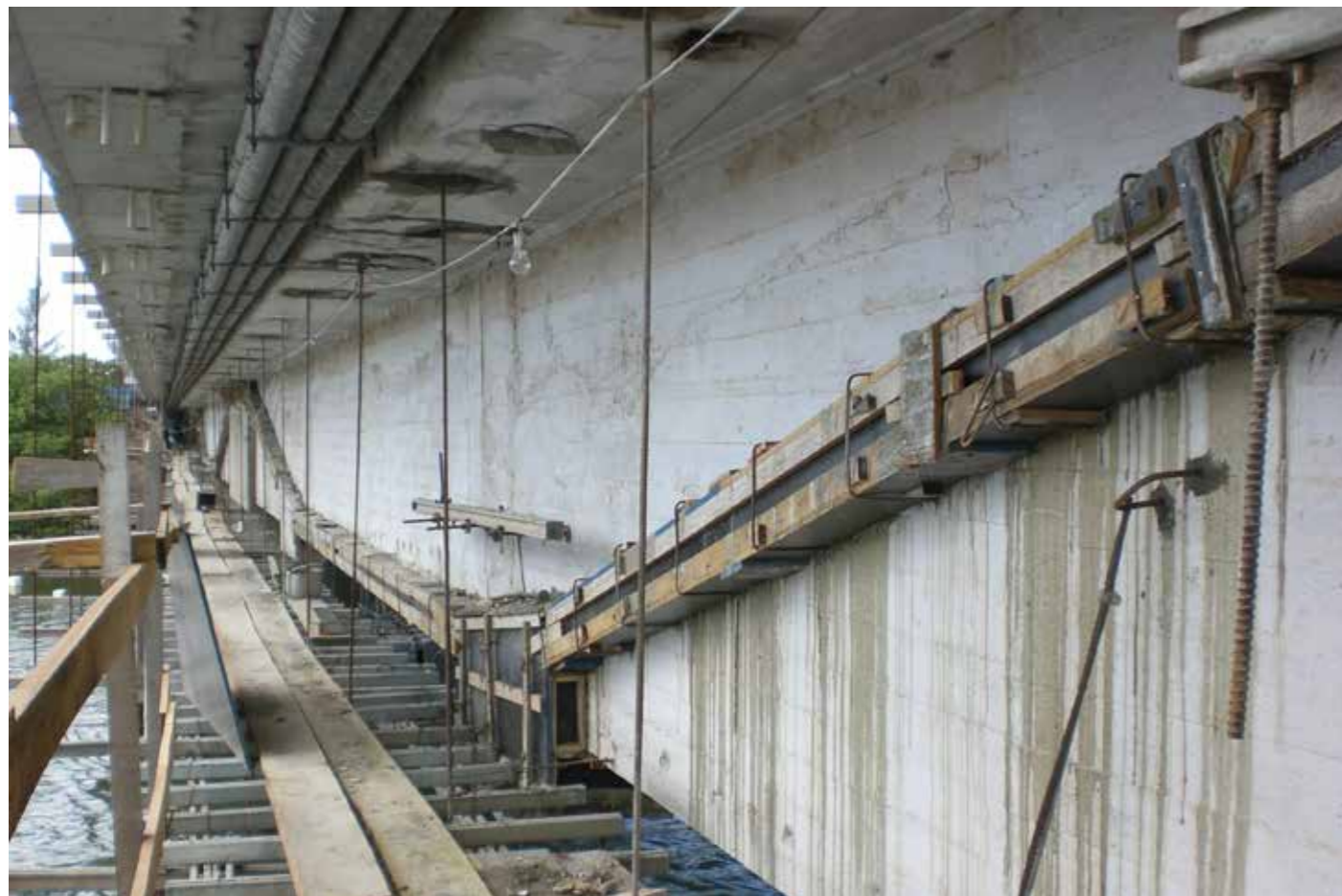
Detalhe do posicionamento do cabo de protensão de reforço.
