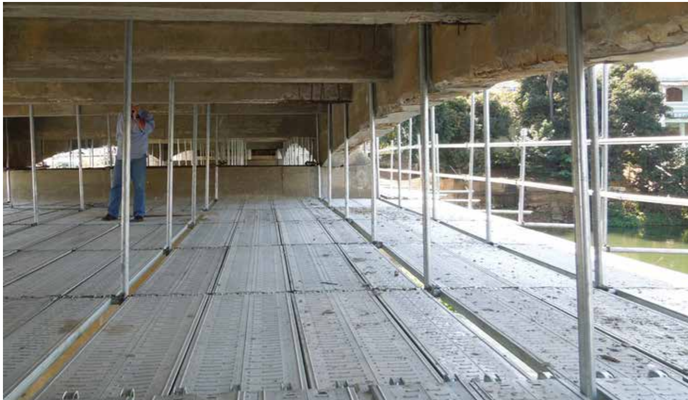
Detalhamento da plataforma suspensa de trabalho e protensão através de cabos constituídos por conjuntos de monocordoalhas engraxadas.
