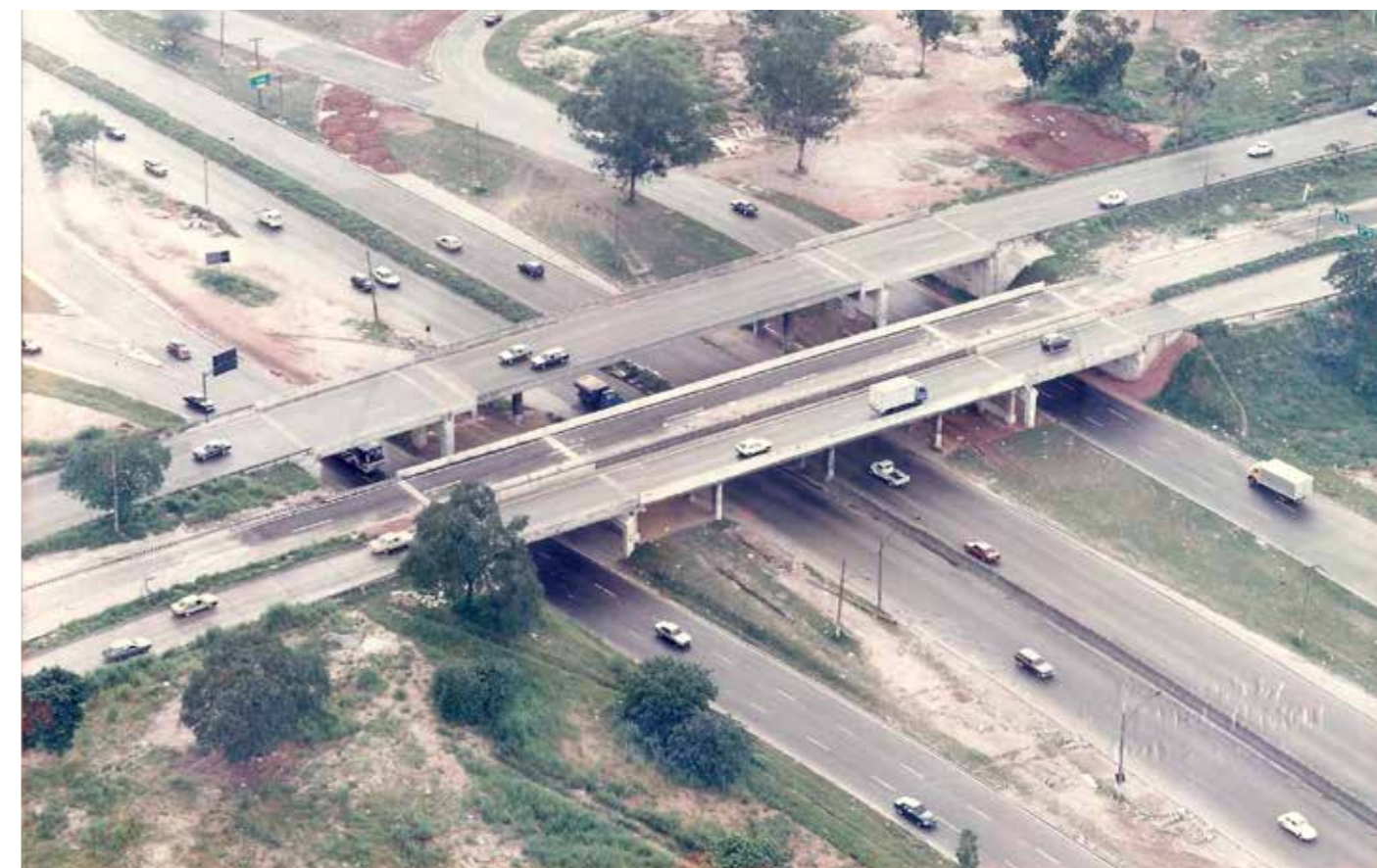
Vista aérea das obras recém-concluídas.
