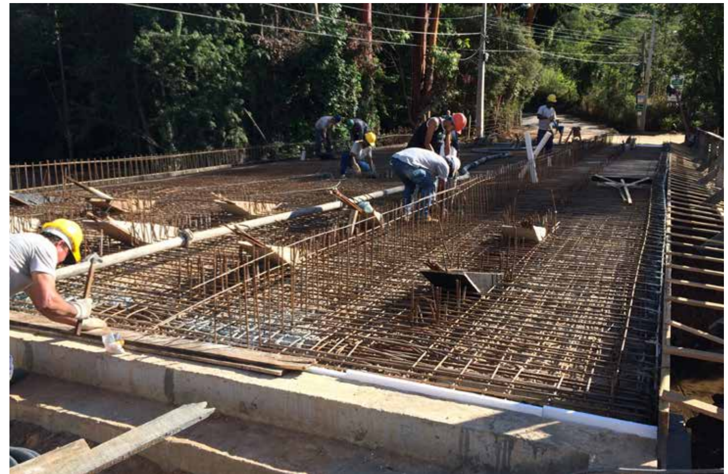
Detalhe da armadura da laje com os nichos para a segunda etapa da protensão.
