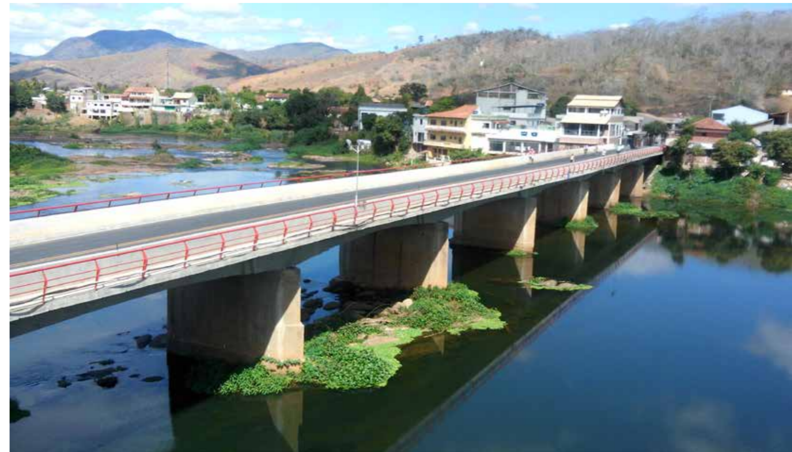
Detalhe da solução para incorporação dos alargamentos visando a acomodação de passeios nas laterais.
