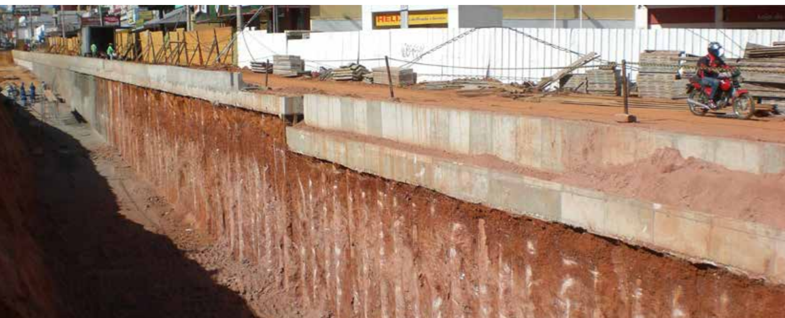
Solução de contenção das paredes laterais em estacas justapostas revestidas em concreto armado projetado.
