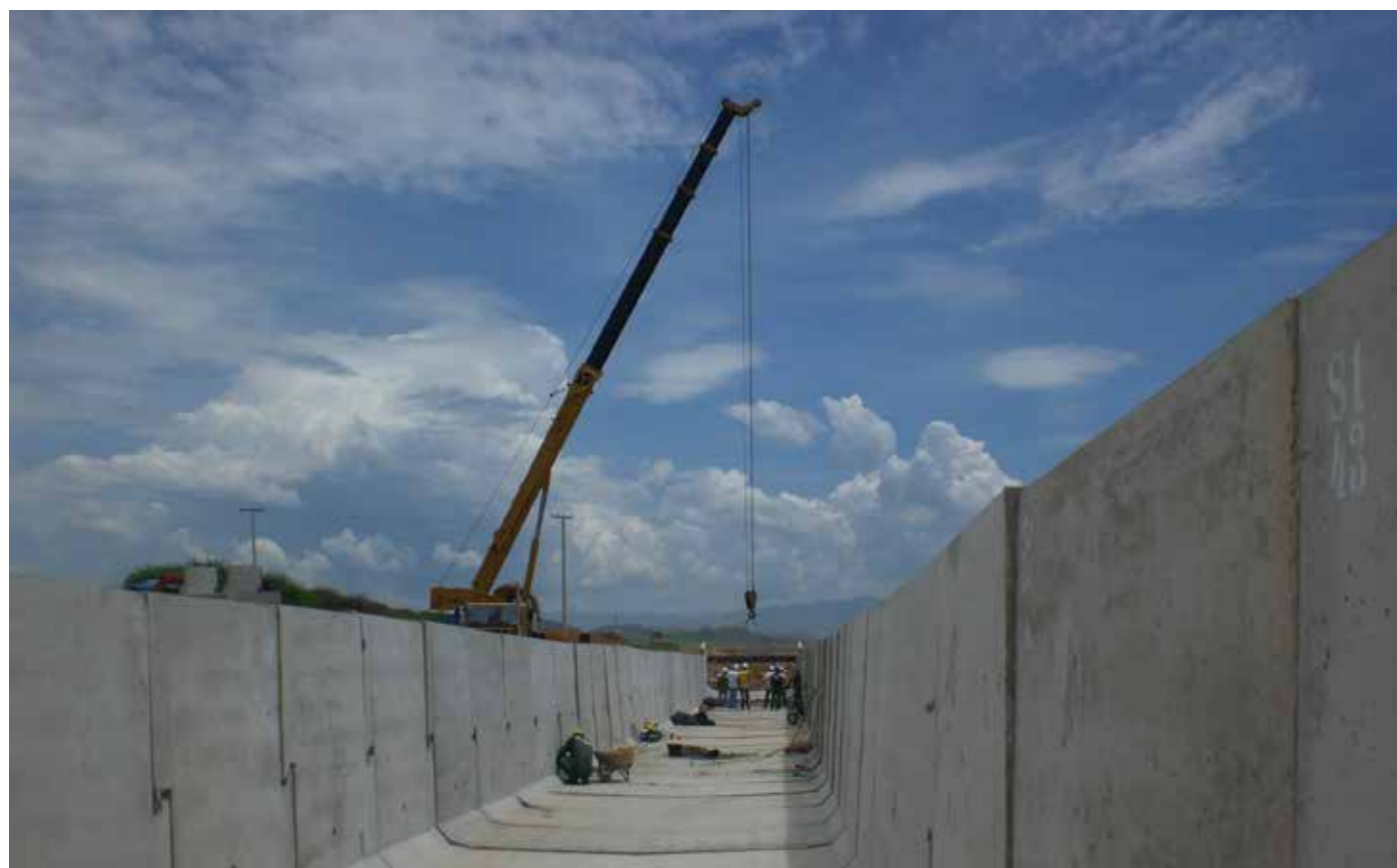
Guindaste fazendo o lançamento do trecho
