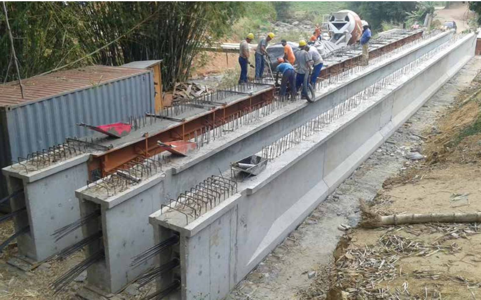
Detalhe das vigas pré-moldadas protendidas com seção I de 1,8 metro de altura e 34 metros de extensão.
