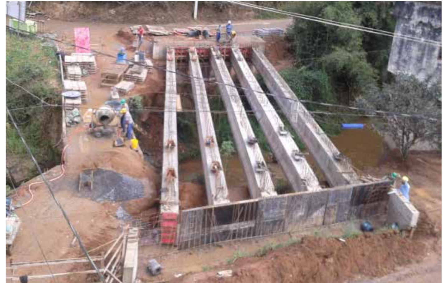
Projeto executivo de super-estrutura em vigas pré-moldadas protendidas.
