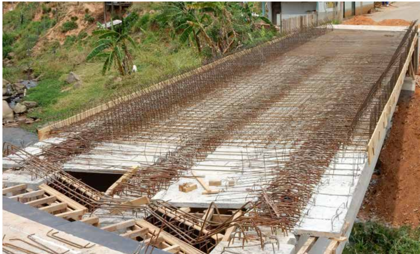
Detalhe da forma da estrutura caracterizada por vigas pré-moldadas com 1,8 metro de altura e 30 metros de extensão.
