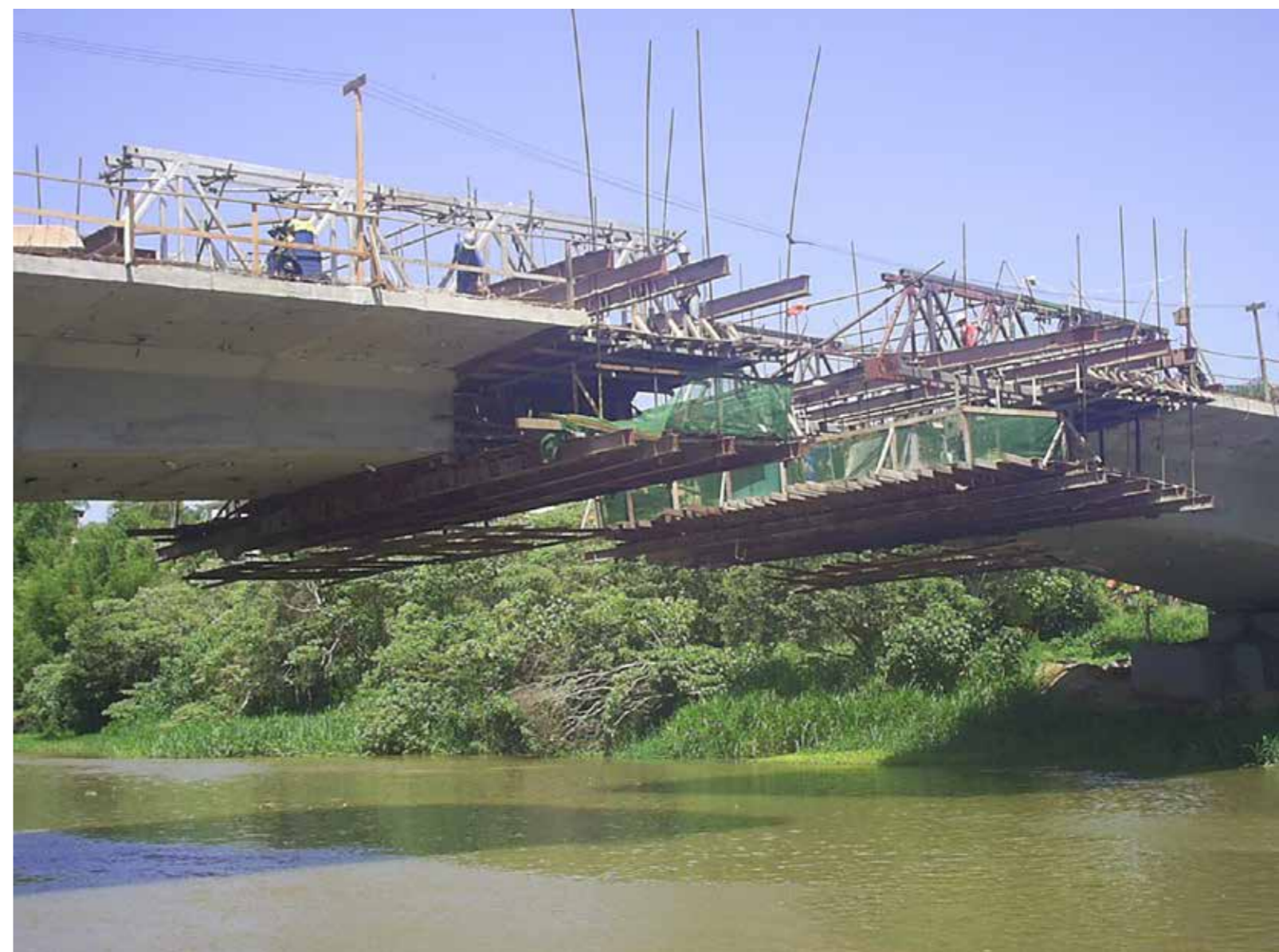
Detalhe da construção das últimas aduelas no trecho do fechamento central.
