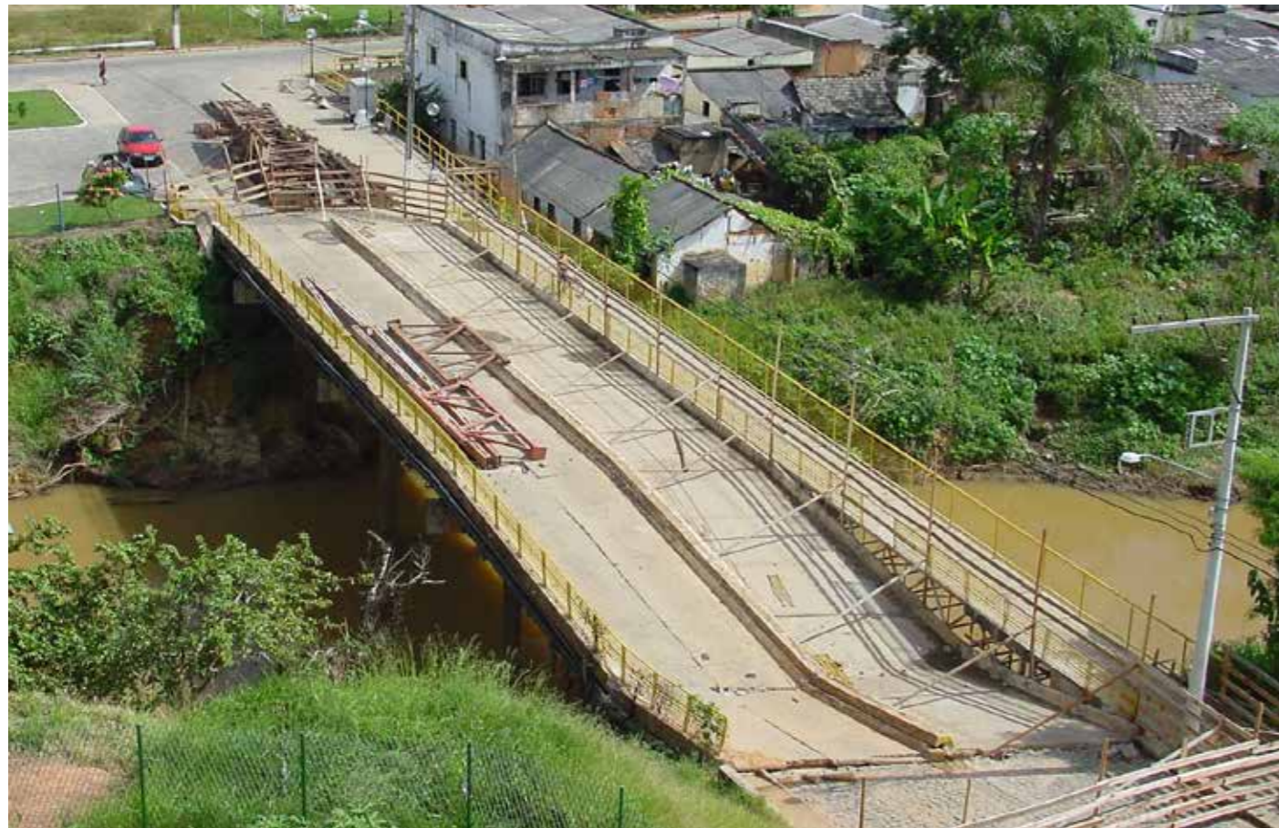
Superestruturas colapsadas da ponte original
