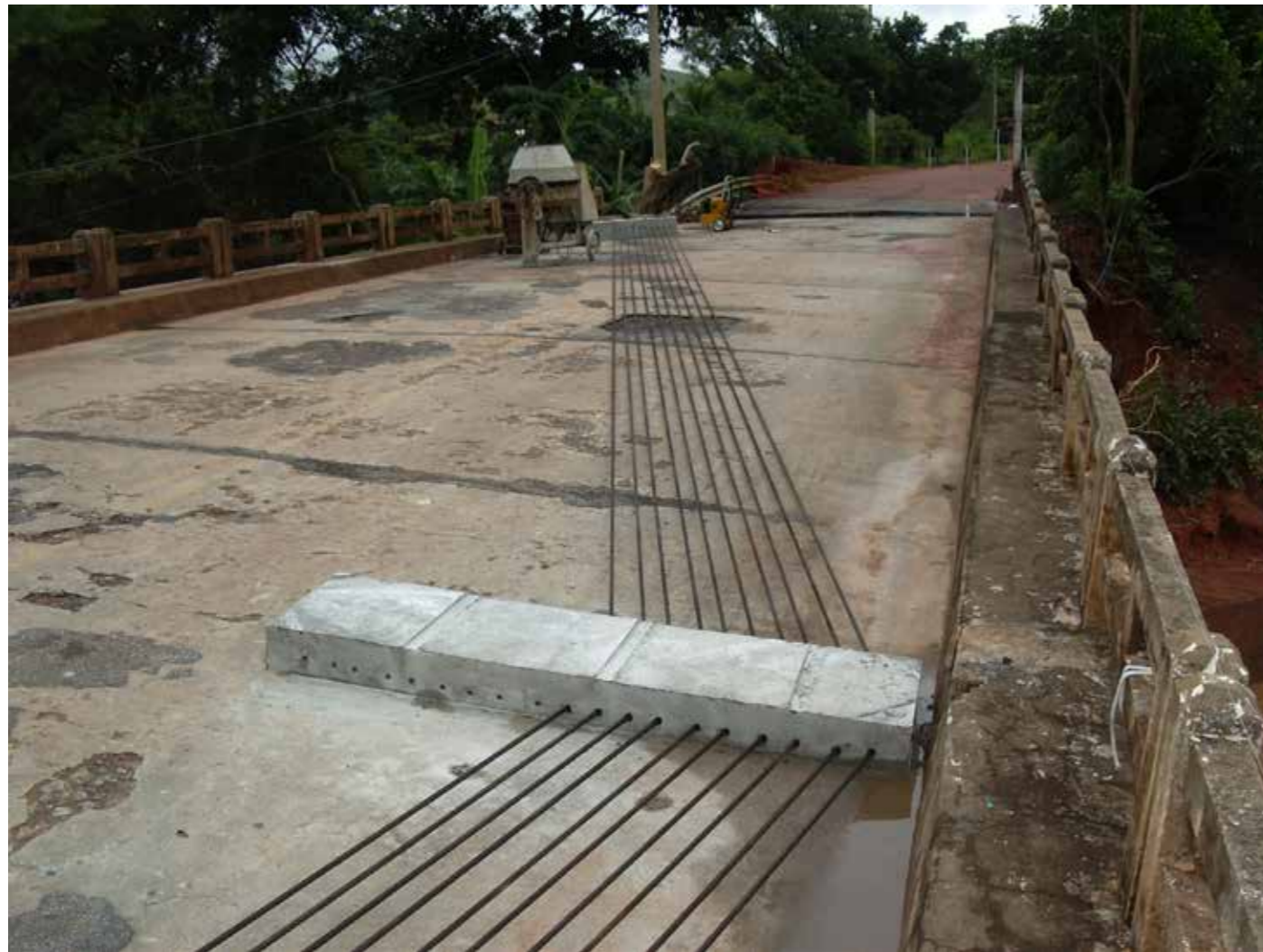
Aspecto de feixe de cordoalhas para protensão emergencial de equilíbrio na laje superior.
