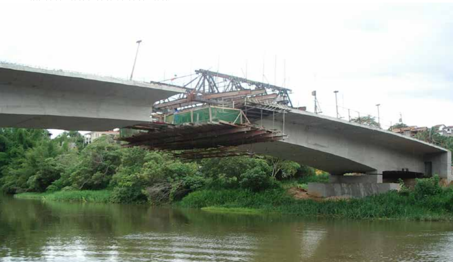
Detalhamento geométrico do projeto estrutural com extensão total de 90 metros e vão central de 60 metros.
