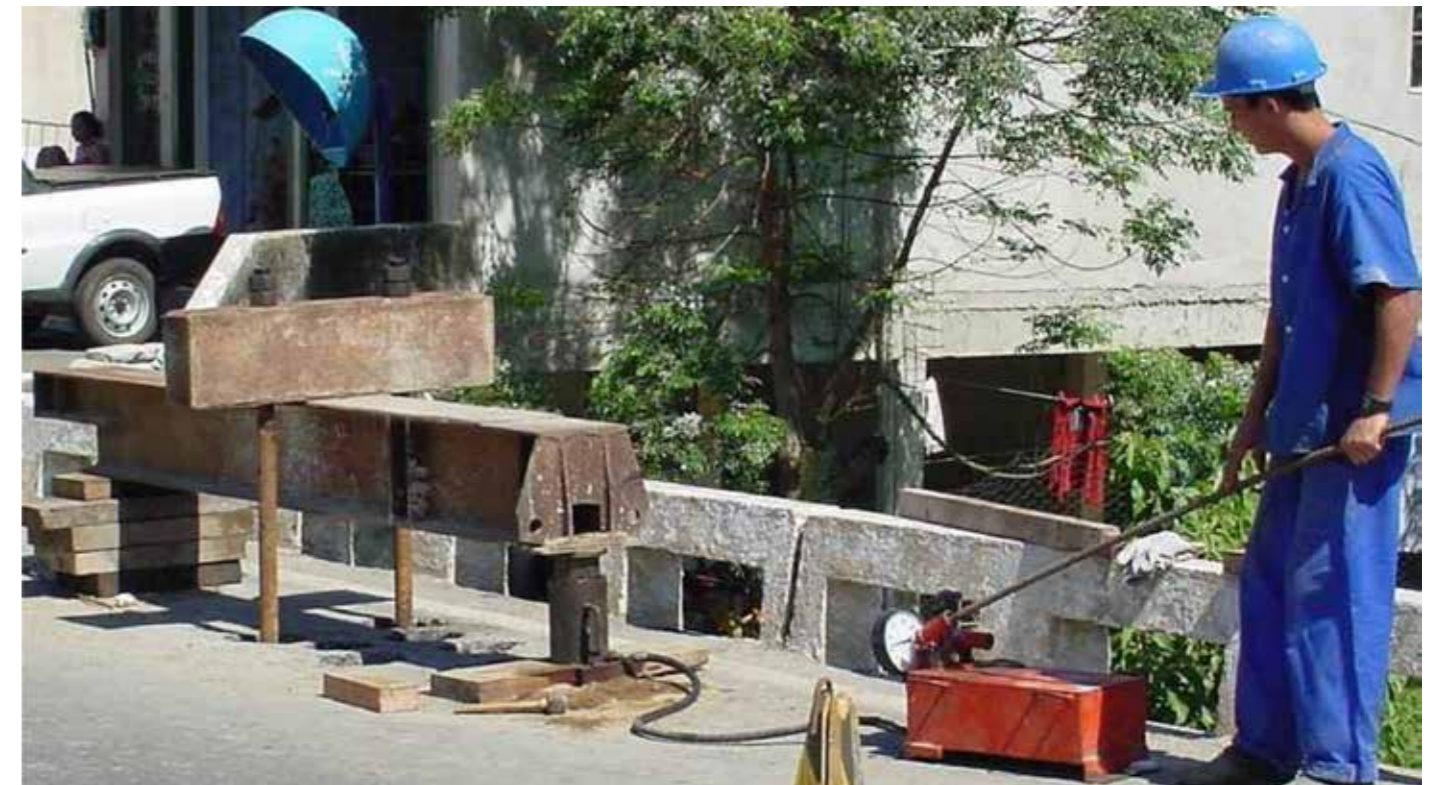
Instante da suspensão do vão com viga "prolonga".
