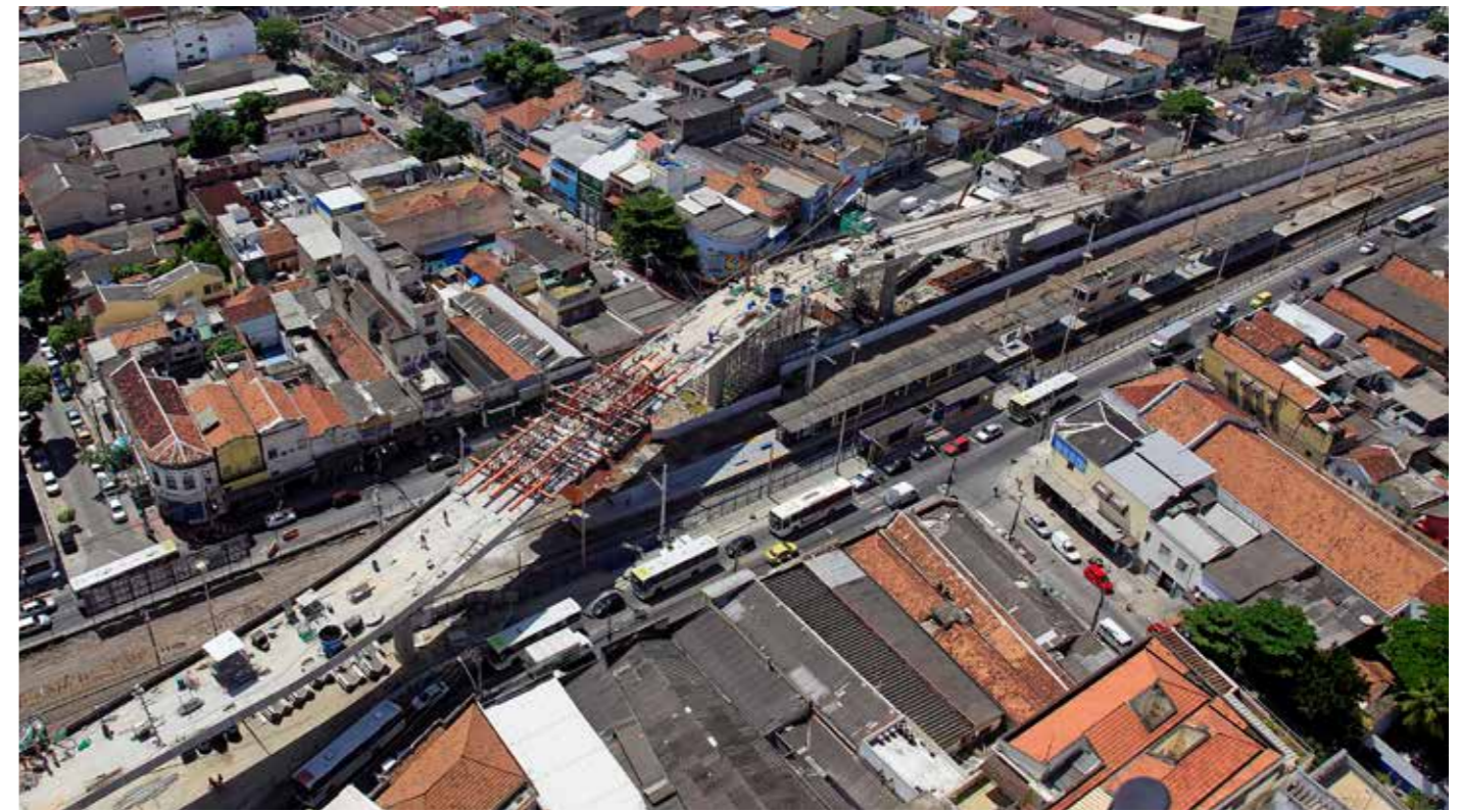
Superestrutura no trecho da travessia sobre a Supervia com vão livre de 62 metros de extensão.
