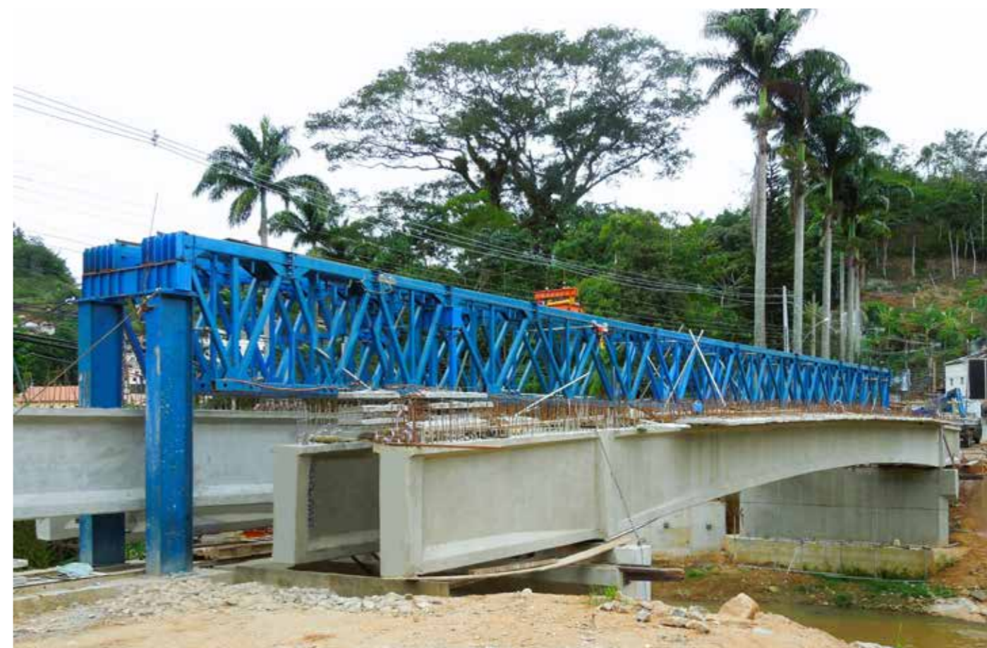
Construção de ponte sobre o Rio Grande, no município de Bom Jardim para a Fundação DER-RJ, em vigas arqueadas protendidas, pré-moldadas, lançadas com estrutura treliçada (2012).
