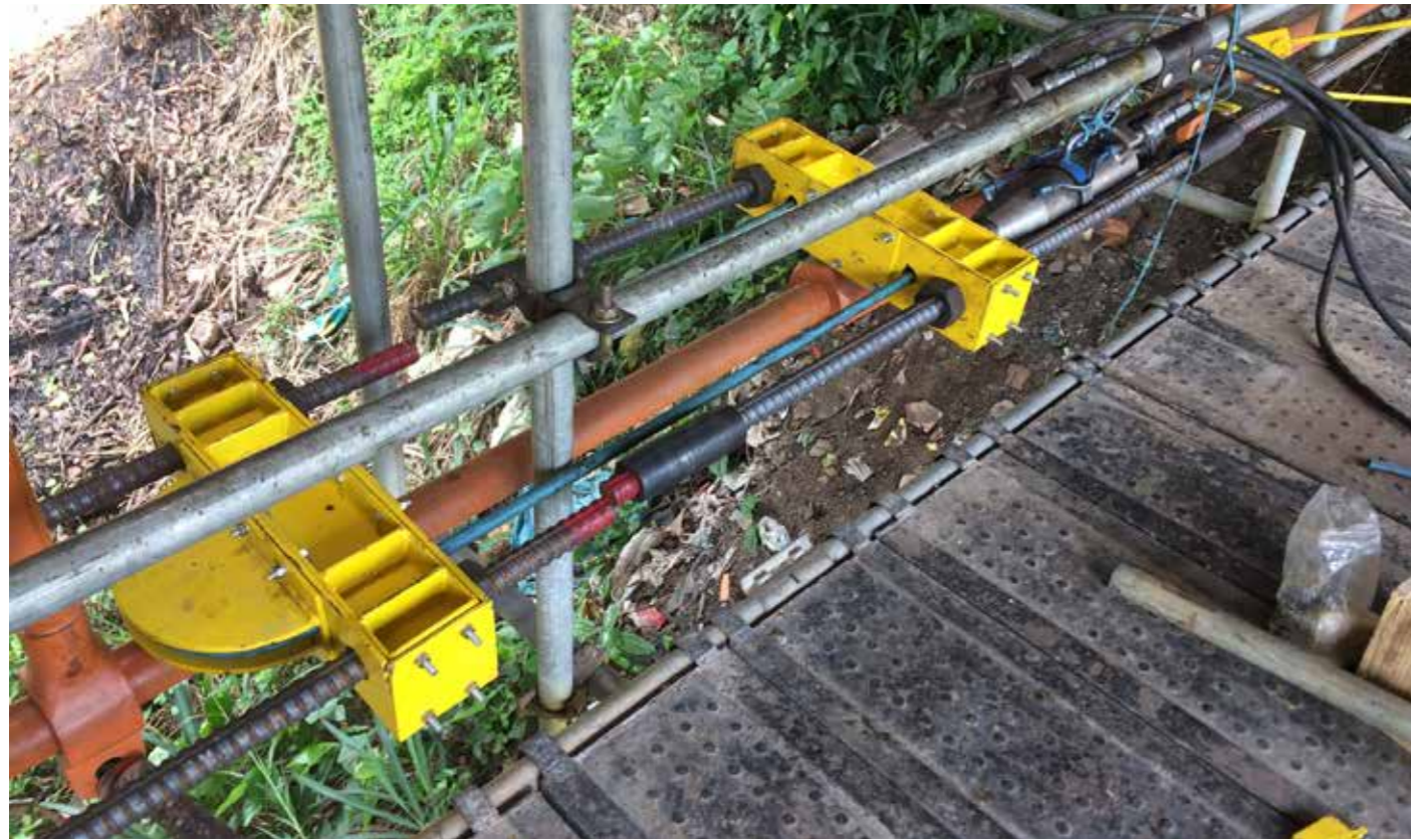
Montagem para aplicação indireta da protensão dos tirantes.
