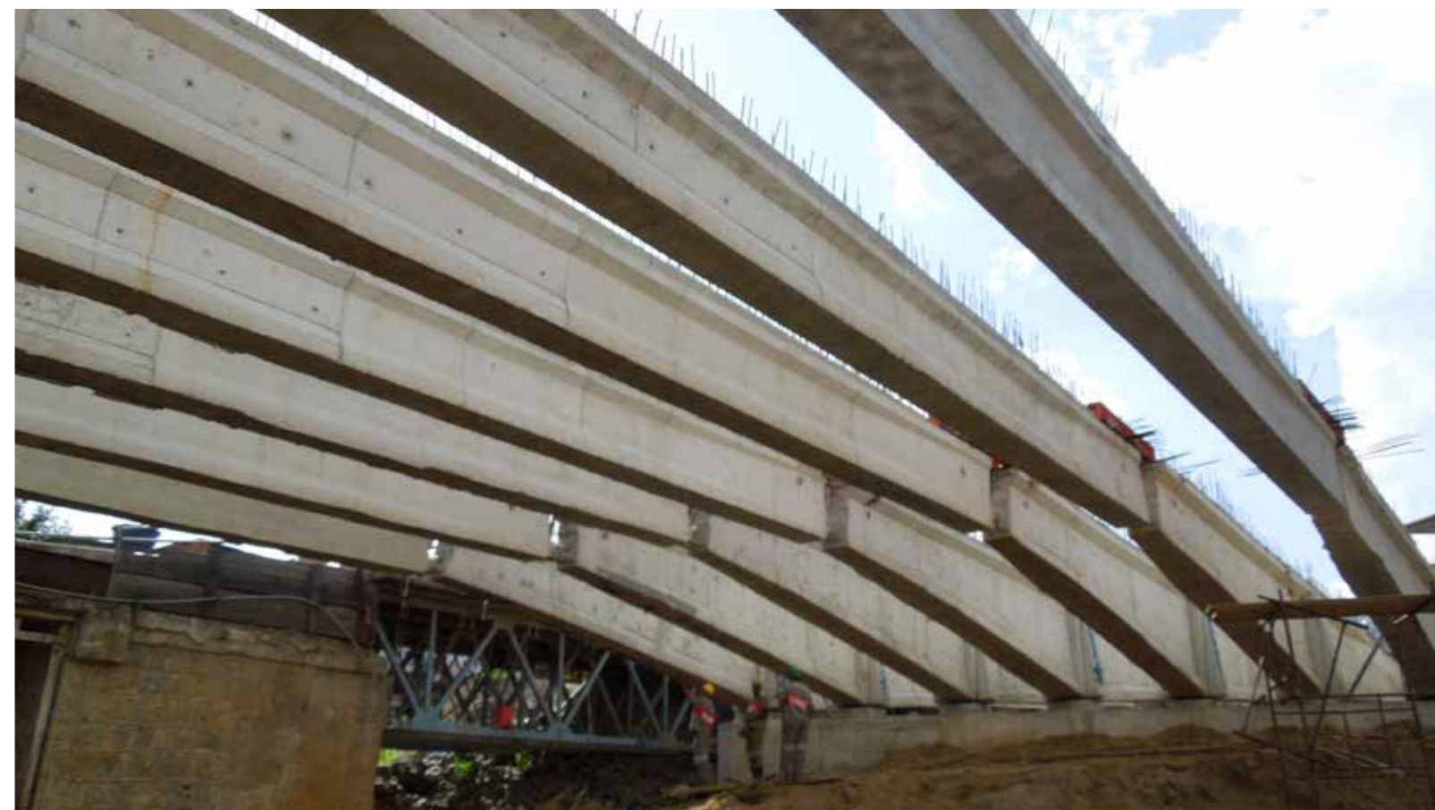
Tirantes para absorção da tração das vigas cavaletes após o posicionamento das vigas centrais.
