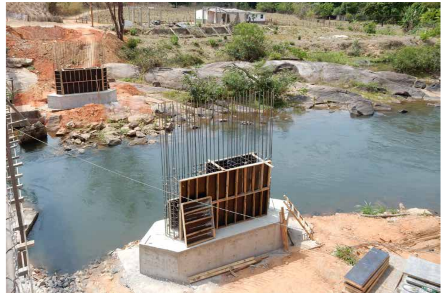
Acima, estudo de etapa construtiva sobre cimbramento em treliça metálica. Abaixo, etapa construtiva da mesoestrutura.
