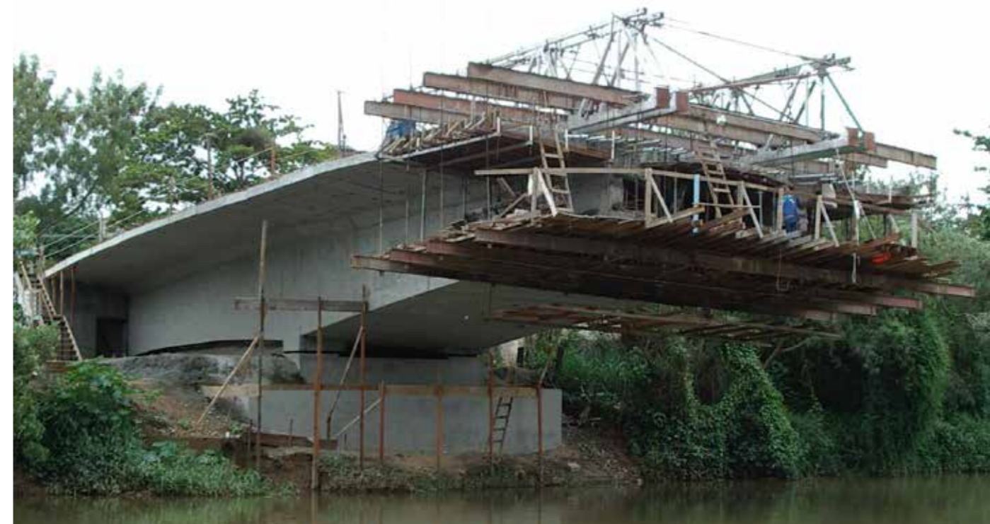
Detalhe da produção da aduela boldada "in-loco" suportada por treliças para balanço progressivo.
