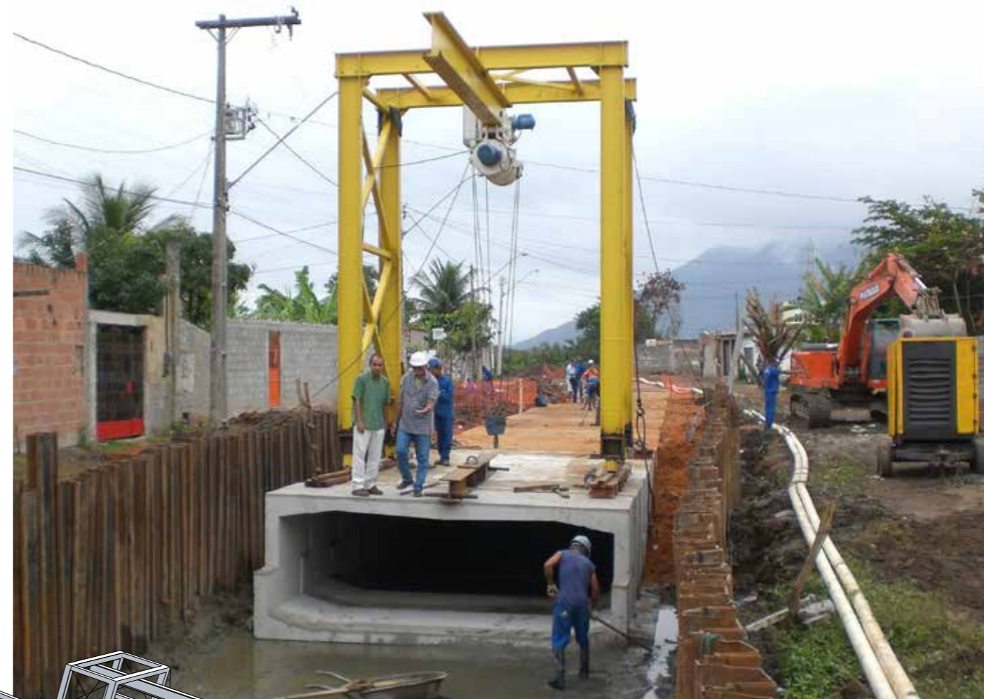
Pórtico de lançamento com aduela recém-posicionada.
